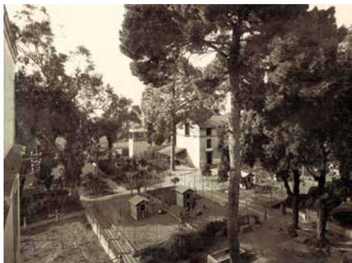
Laboratorio di Zootecnia: piazzale con i pollai; sullo sfondo il fienile e il silos per i foraggi.
