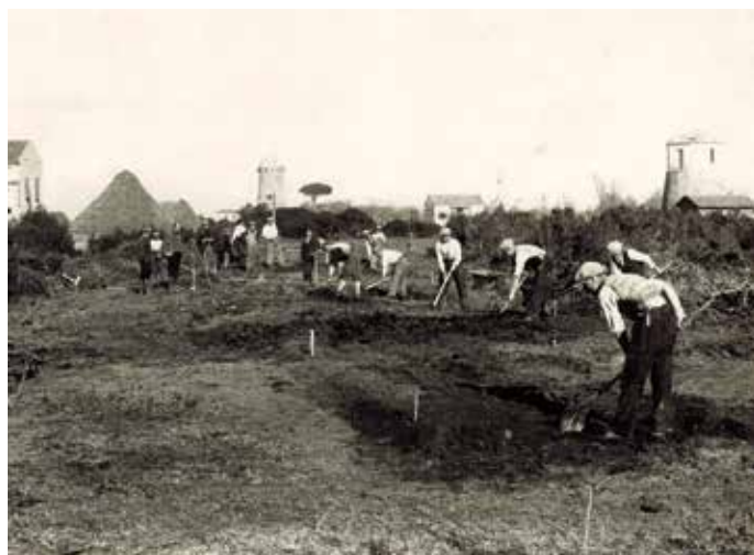
Impianto idrovoro alla foce del fiume Sele: costruzione della strada di accesso all'impianto (sinistra); sala macchine con quattro pompe assiali collegate a motori elettrici (destra). L'impianto fu costruito dal 1933 al 1937 e consentiva il sollevamento delle acque provenienti dalle zone basse, dove erano localizzate le paludi del Sele morto e di Varolato.
