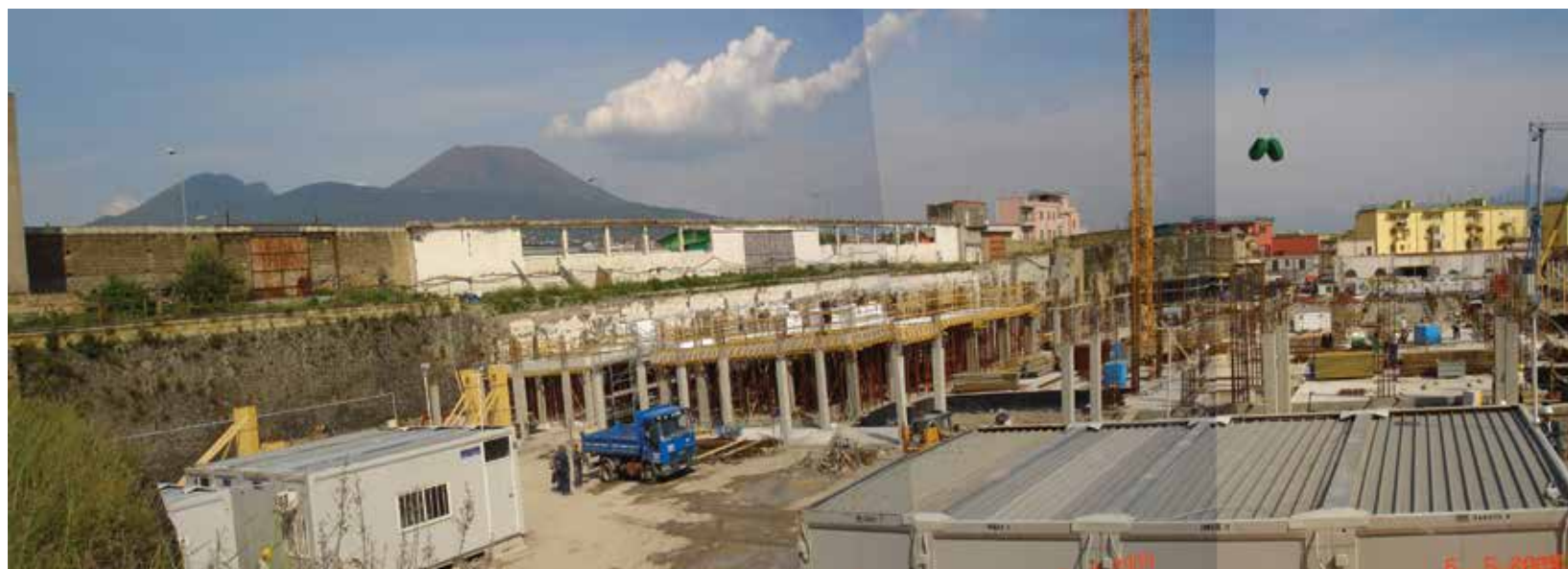
Stato dei lavori per la costruzione del nuovo Polo universitario e di ricerca nel maggio 2009.
