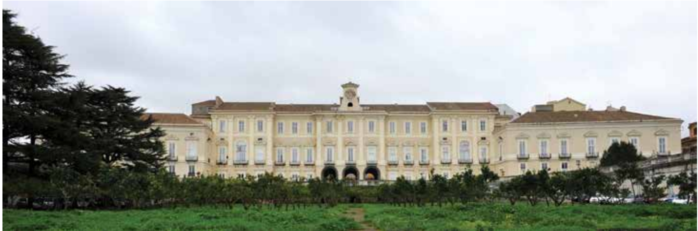
La facciata della Reggia verso il mare dopo i recenti restauri (foto di Lucio Terracciano del Dipartimento di Studi Umanistici dell'Università degli Studi di Napoli Federico II).
