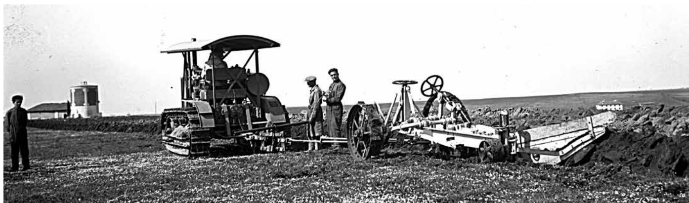
Prova di lavorazione profonda del terreno.
