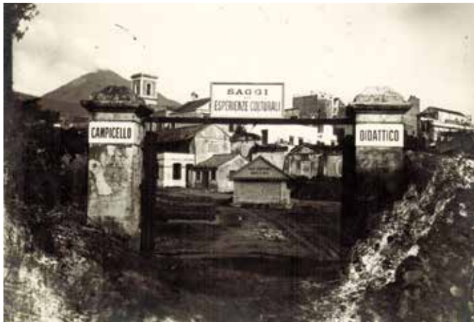
Ingresso del campicello didattico nel Parco Gussone.
