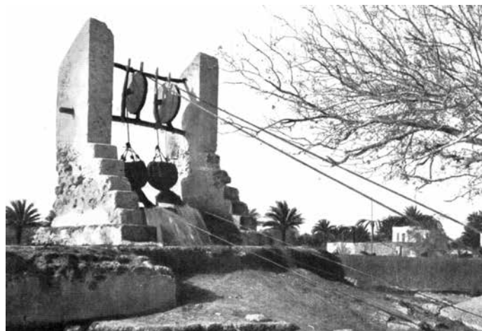
Libia: sistema di estrazione dell'acqua da un pozzo con due carrucole, otri e animali che muovono in una pista in discesa; gli animali all'inizio della discesa (a sinistra); gli animali alla fine della discesa e l'acqua che viene versata dagli otri in un pozzetto di raccolta (a destra).
