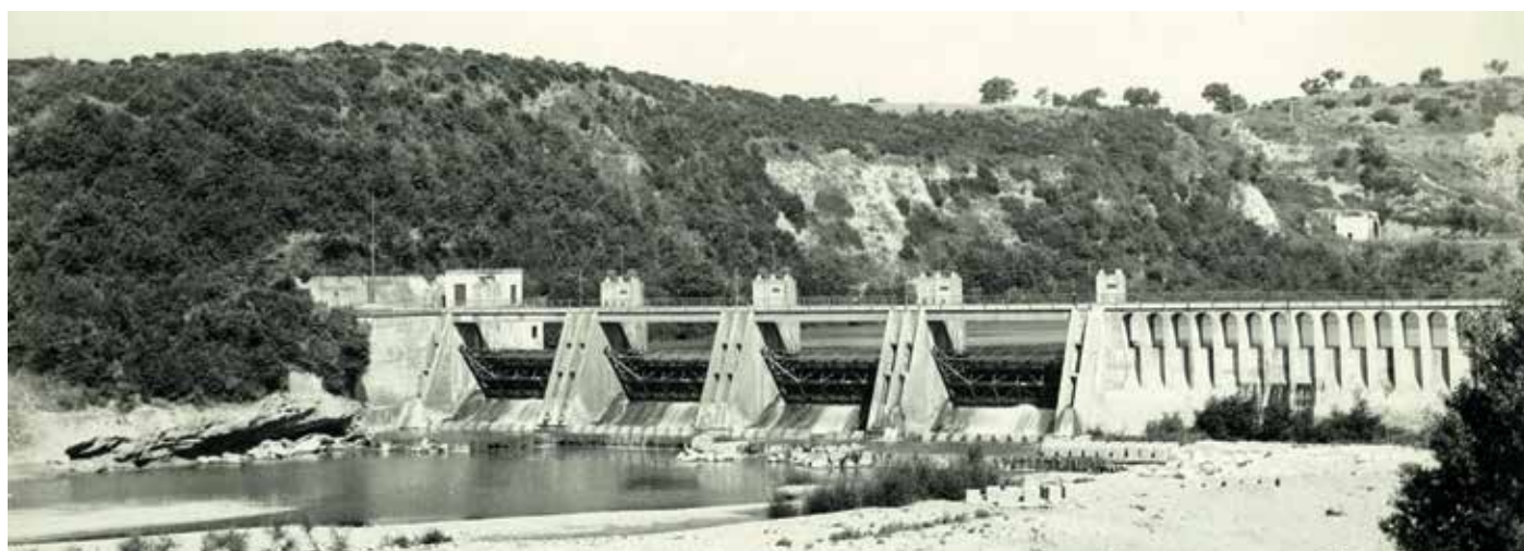
Traversa di Persano per la derivazione delle fluenze del Sele, da utilizzare per l'irrigazione della pianura litoranea. La traversa fu inaugurata nel 1934.
