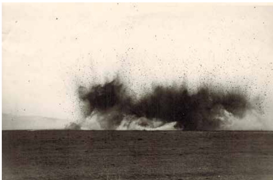
Prova di dissodamento del terreno con esplosivi; Agro Romano, 1931.
