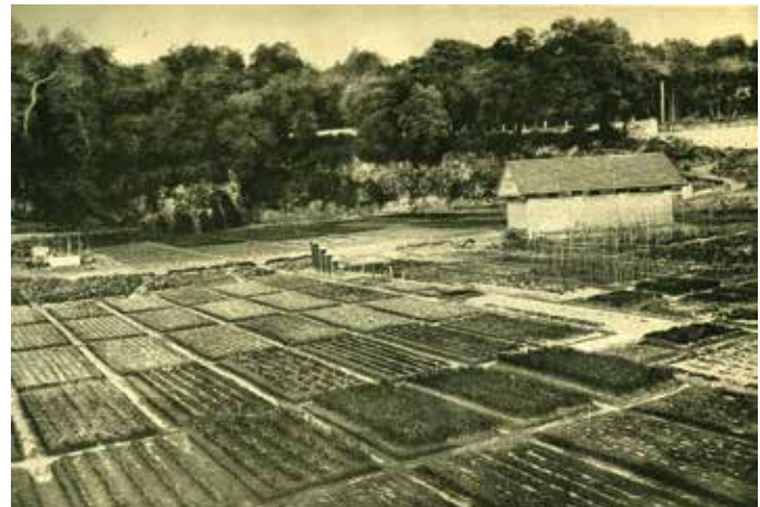
Vista del campicello didattico nel Parco Gussone; al centro il silo Guffart.
