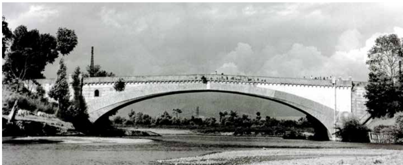
Ponte del Diavolo sul fiume Sele in località Barizzo, foto recente.
