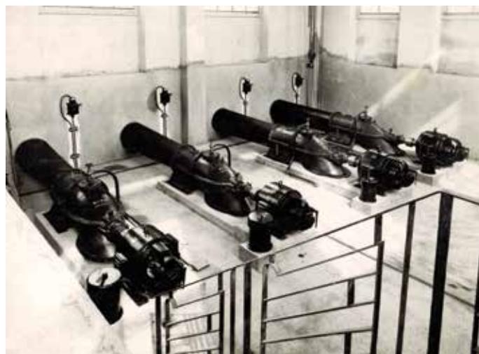
Impianto idrovoro alla foce del fiume Sele: costruzione della strada di accesso all'impianto (sinistra); sala macchine con quattro pompe assiali collegate a motori elettrici (destra). L'impianto fu costruito dal 1933 al 1937 e consentiva il sollevamento delle acque provenienti dalle zone basse, dove erano localizzate le paludi del Sele morto e di Varolato.
