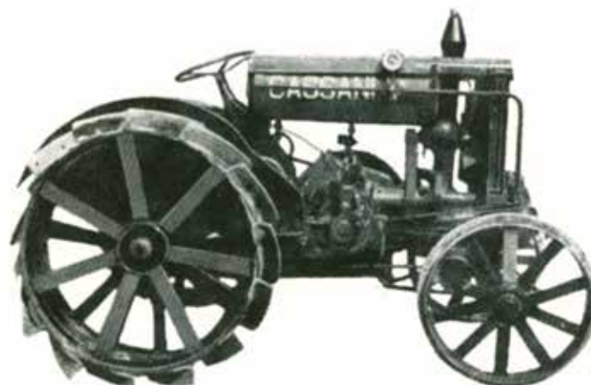
Trattrice Cassani, prima trattrice azionata da motore Diesel (1927).
