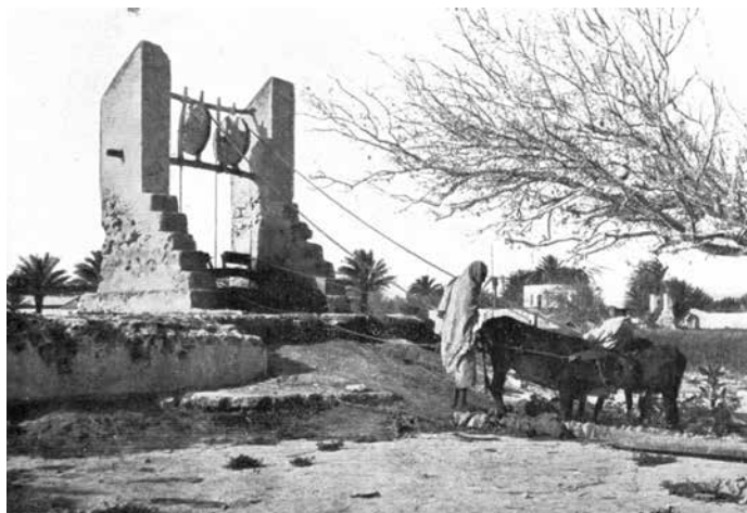
Libia: sistema di estrazione dell'acqua da un pozzo con due carrucole, otri e animali che muovono in una pista in discesa; gli animali all'inizio della discesa (a sinistra); gli animali alla fine della discesa e l'acqua che viene versata dagli otri in un pozzetto di raccolta (a destra).
