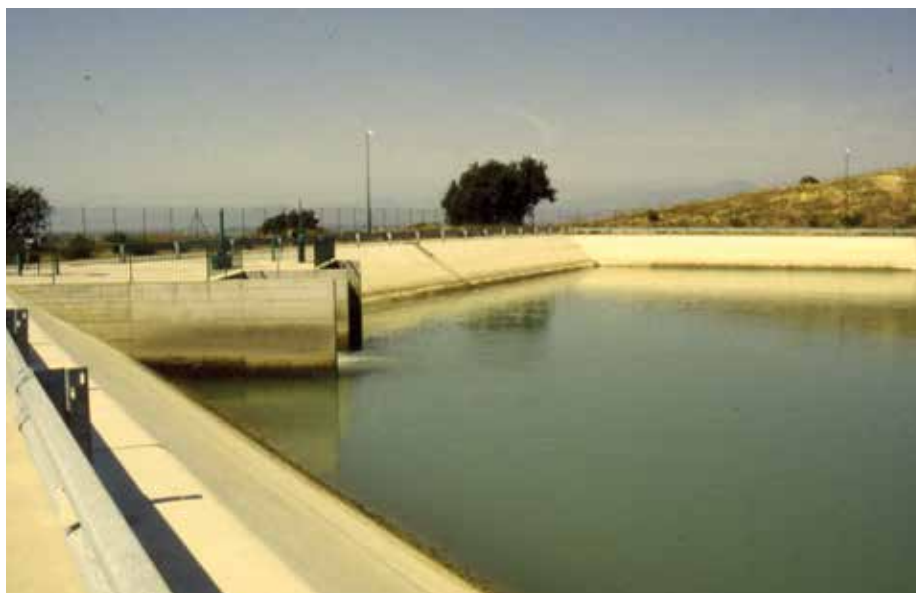
Consorzio di bonifica della Capitanata (Foggia), rete irrigua del Fortore, manufatti di disconnessione e compenso: torrino di disconnessione per contenere la pressione a regime nella zona bassa del Sud-Fortore (a sinistra); vasca di compenso per la regolazione delle portate nella rete (a destra).
