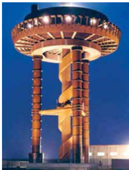
Consorzio di bonifica della Capitanata (Foggia), rete irrigua del Fortore, manufatti di disconnessione e compenso: torrino di disconnessione per contenere la pressione a regime nella zona bassa del Sud-Fortore (a sinistra); vasca di compenso per la regolazione delle portate nella rete (a destra).
