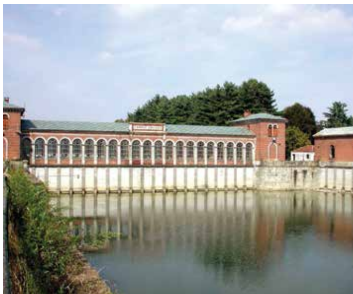
Opera di presa del canale Cavour dal Po a Chivasso vista da valle.
