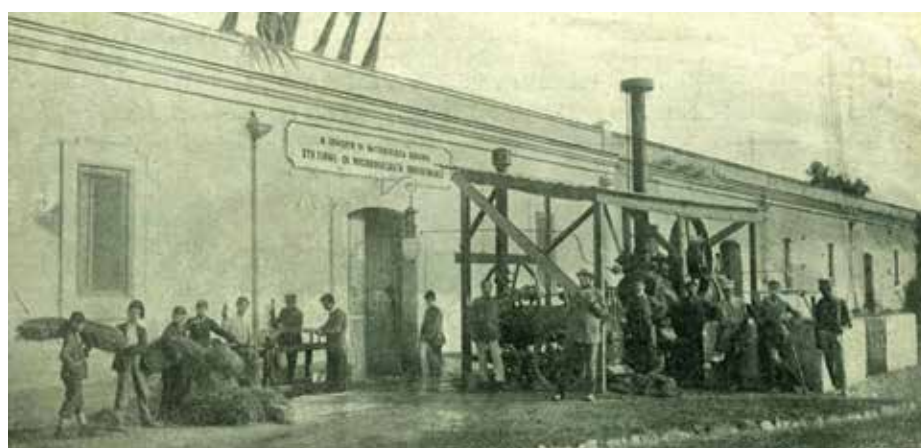
Tentativi per la macerazione industriale delle fibre tessili con fermenti selezionati nella Stazione di microbiologia industriale: impianto di macerazione del lino (1909). La figura mostra una locomobile per l'insufflazione di aria alle caldaie di macerazione (collezione V. Proto). Istituto di Batteriologia: Stazione agricola antimalarica.
