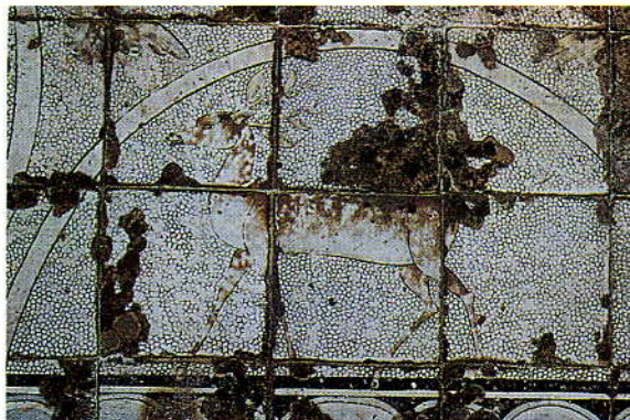
Pavimento maiolicato del Belvedere: particolare del cervo.
