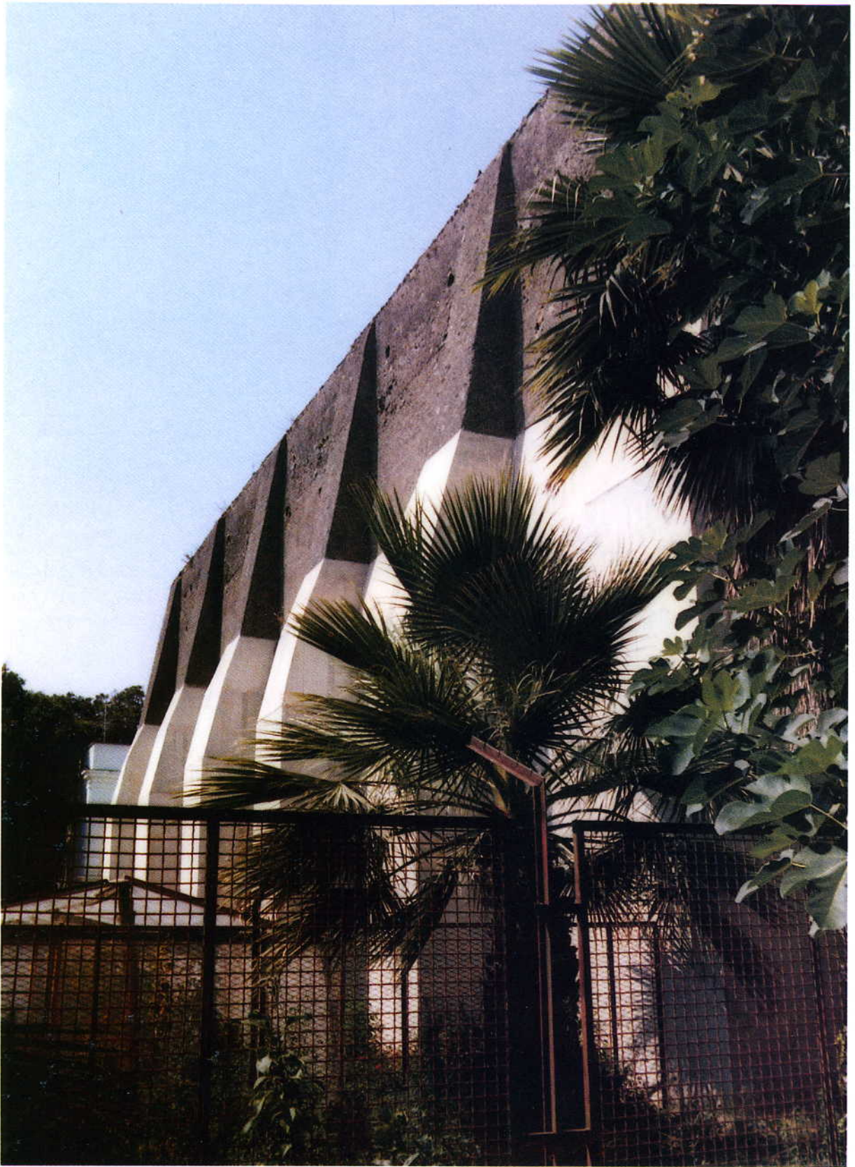
Il Muro terminale del Giardino costruito originariamente per il Gioco del Pallone, allo stato attuale dopo gli interventi di rinforzo statico.
