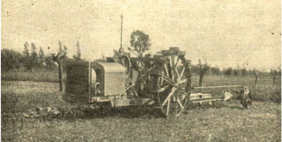
Figura 21. Motoaratrice della Stock Motorpflug Gesellschaft di Berlino: un primo modello fu costruito nel 1907 con tre corpi di aratro montati su uno stesso telaio sul quale era posto anche un motore a benzina di 6 kW, successivamente il motore fu potenziato (31 kW) e i corpi di aratro furono portati a sei; possedeva due ruote motrici, di grande diametro con poche palette, sulle quali gravava quasi tutto il peso della macchina in quanto il peso degli aratri e del motore si equilibravano ed erano posti da parti opposte dell'asse delle ruote motrici.
