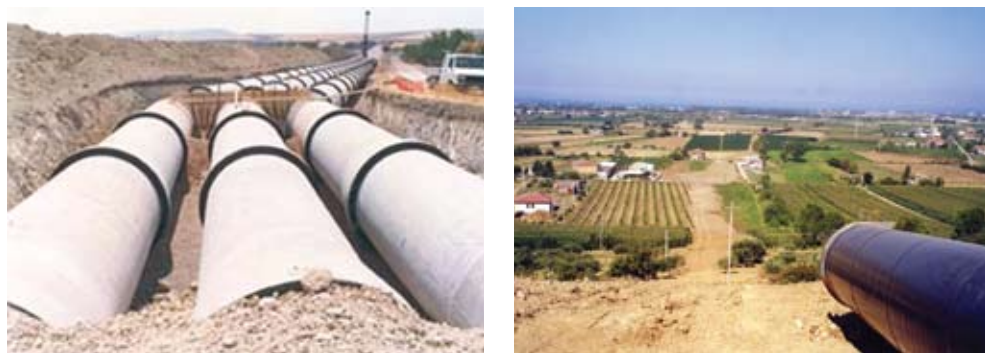
Figura 67. Rete di irrigazione in pressione del Comprensorio del Fortore (Foggia): posa delle condotte (a sinistra); ammodernamento della rete d'irrigazione nella piana di Paestum (a destra).
