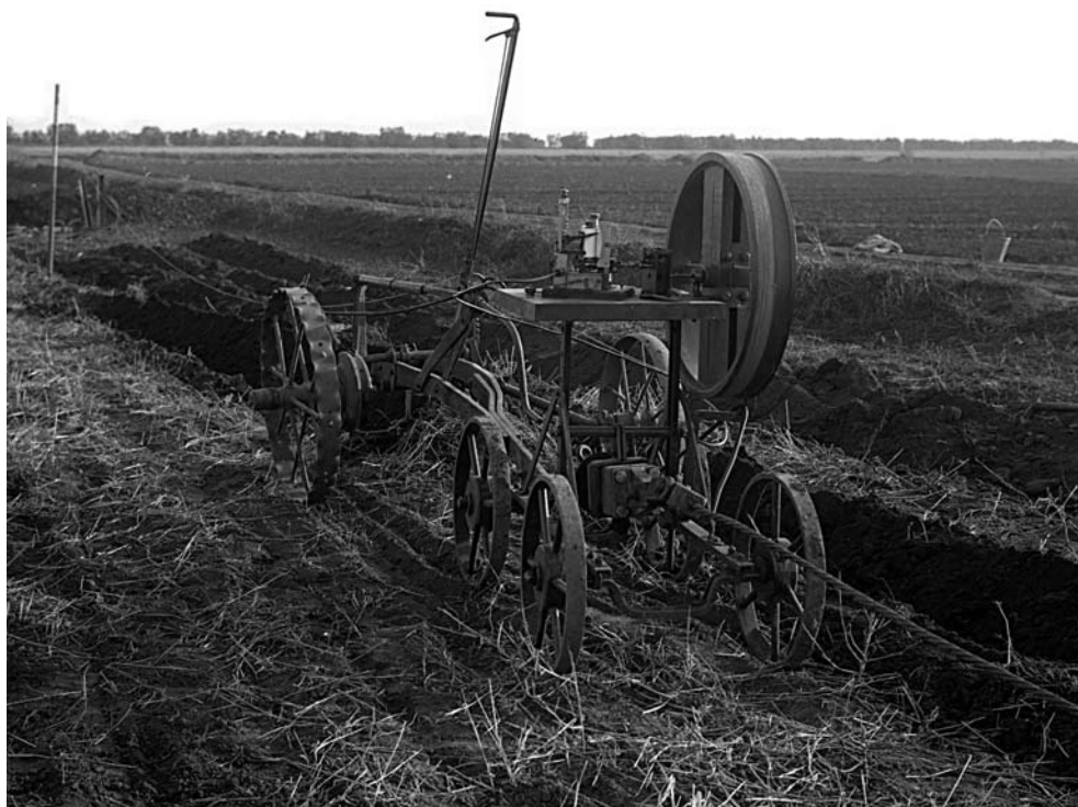
Figura 46. Prove per la determinazione del rendimento e dell' indice di aderenza delle trattrici: carrello dinamometrico con registrazione.
