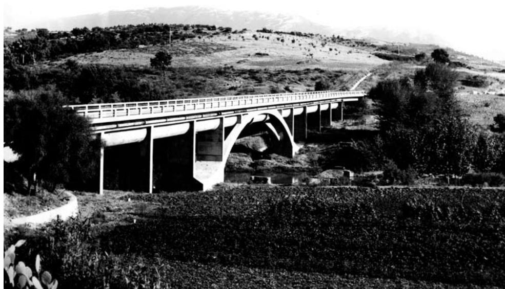
Figura 54. Consorzio di bonifica di Paestum: ponte sifone (rovescio) sul canale principale d'irrigazione per l'attraversamento del torrente La Cosa (1950).
