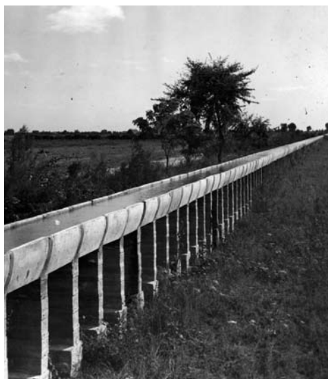
Figura 55. Consorzio di bonifica di Paestum: cantiere per elementi prefabbricati (in alto); deposito degli elementi di canalizzazione prefabbricati (a sinistra); rete terziaria d'irrigazione con elementi prefabbricati (a destra).
